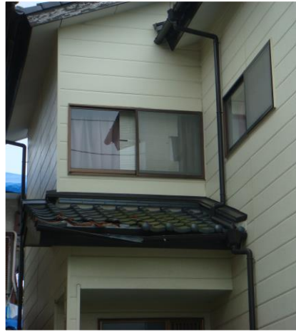
比較的被害が少ない 熊本市北区清水の住宅 瓦が割れて一部落下
