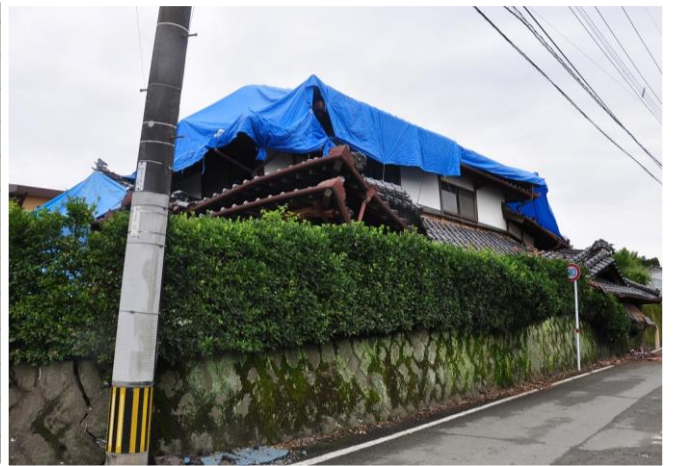
建物がつぶれ・傾き ブルーシートで覆われた 益城町の住宅
