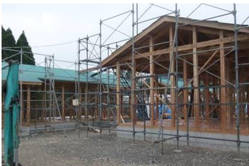
棟上げまで終了していた山都町の現場
