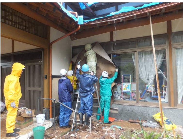
急ぎよカーペットで補修した 3日
