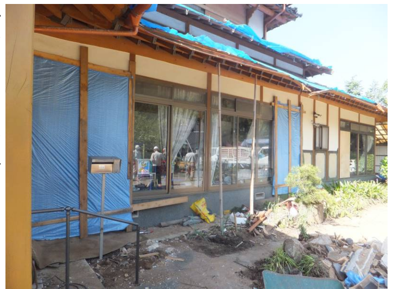
ブルーシートを準備しての補修 4日
